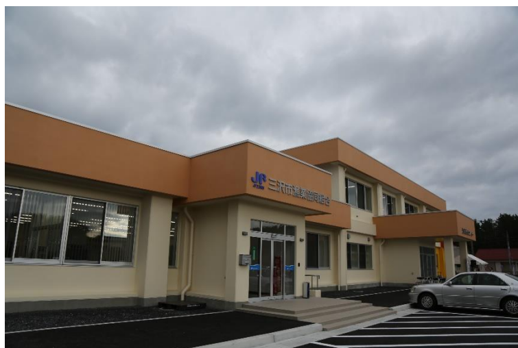
新築移転した漁民研修センター
