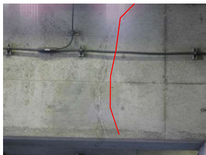
トンネル老朽化状況例（左：ひびわれ 右：うき）
