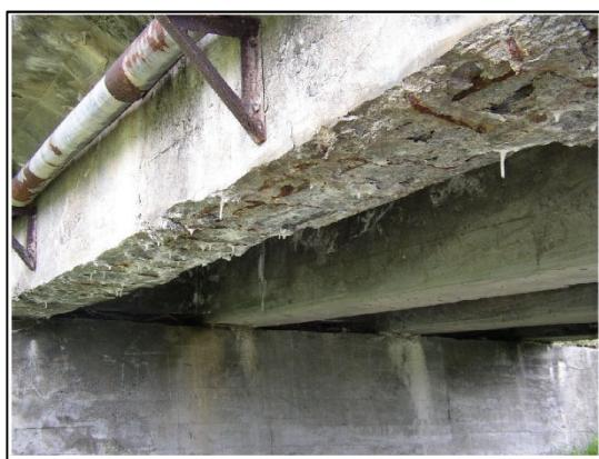
**凍害:**冬期間の凍結融解作用で、主桁下面のかぶりコンクリートがはく離し、一部鉄筋が露出しているのが確認される。
