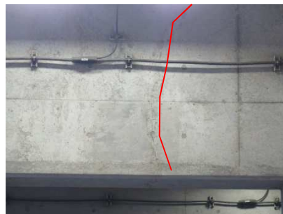
トンネル老朽化状況例（左：漏水・遊離石灰 右：ひび割れ）
