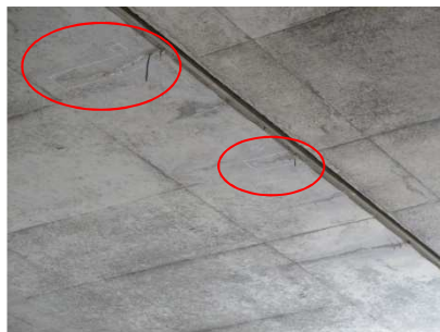
トンネル老朽化状況例（左：漏水・遊離石灰 右：ひび割れ）
